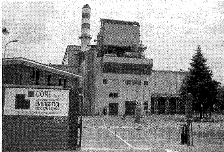
L'impianto di termovalorizzazione CORE SpA
